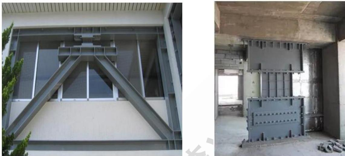
图 4 金属屈服型阻尼器
